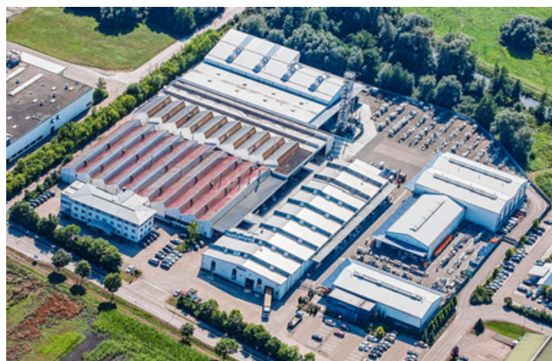
Die bisherige Firmenzentrale von Geda in Bäumenheim scheint angesichts des Wachstums der Firma zu klein. Foto: Geda
